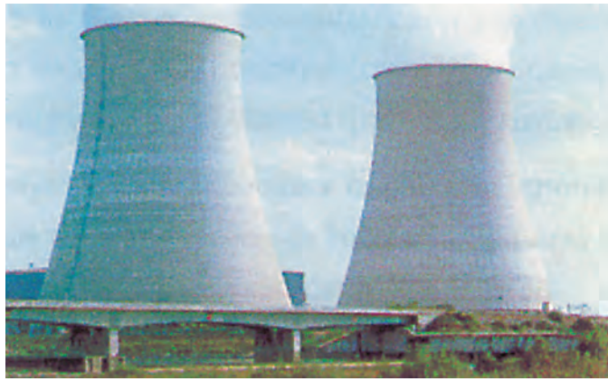
Φωτ. 13.10. Πύργοι ΔΕΗ από οπλισμένο σκυρόδεμα.
