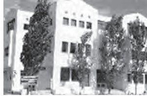
Φωτ. 13.2. Τριώροφη κατασκευή από οπλισμένο σκυρόδεμα.
