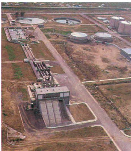
Φωτ. 1.7. Εγκαταστάσεις βιολογικού καθαρισμού Θεσσαλονίκης.
