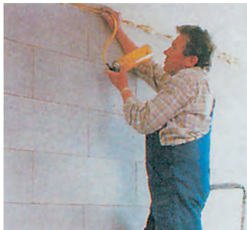
Φωτ. 10.27. Σφήνωμα με διογκωμένη πολυουρεθάνη.
