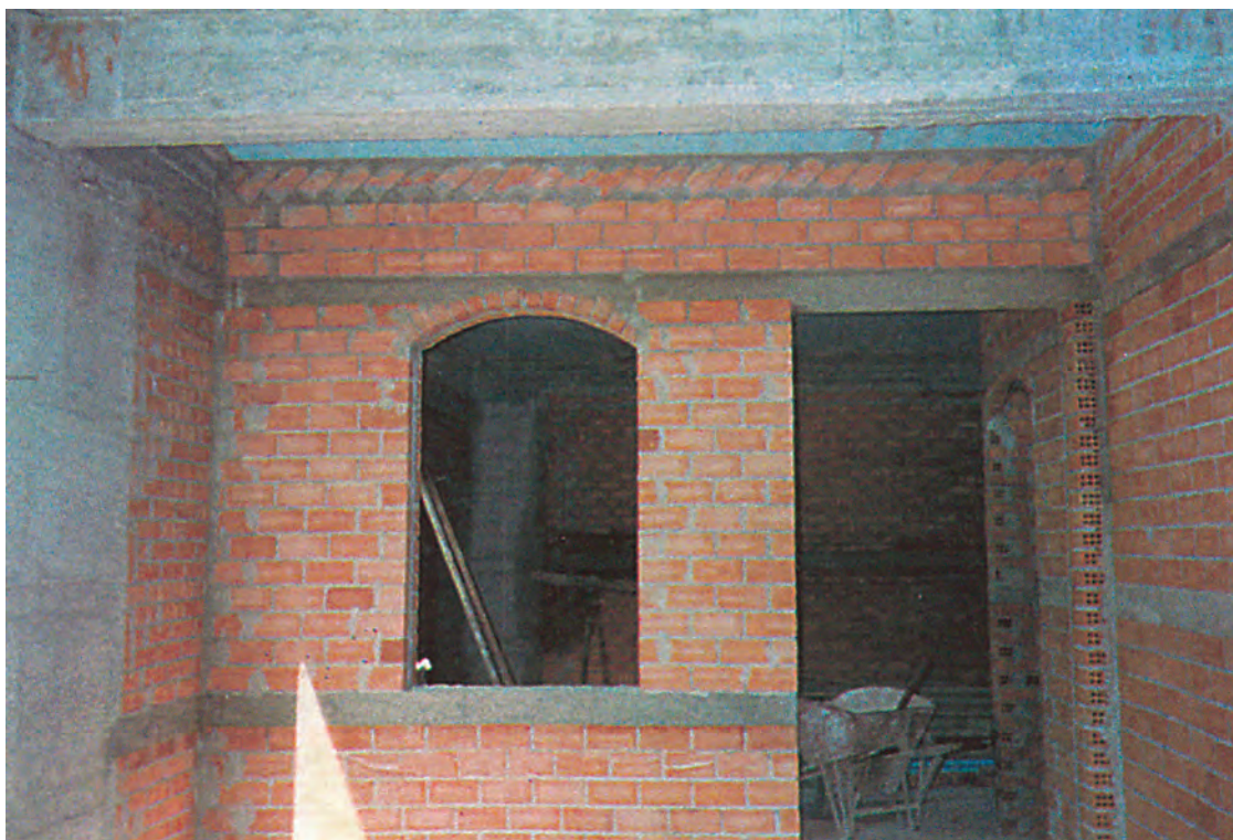
Φωτ. 10.9. Όψη τοίχου με σενάζ και ανοίγματα.
