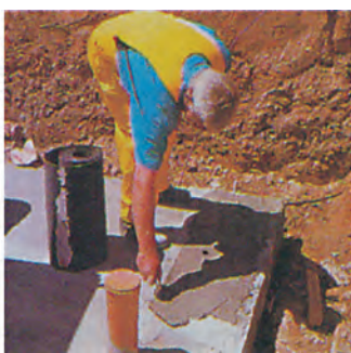
β. Κονίαμα και υγρομόνωση βάσης.
