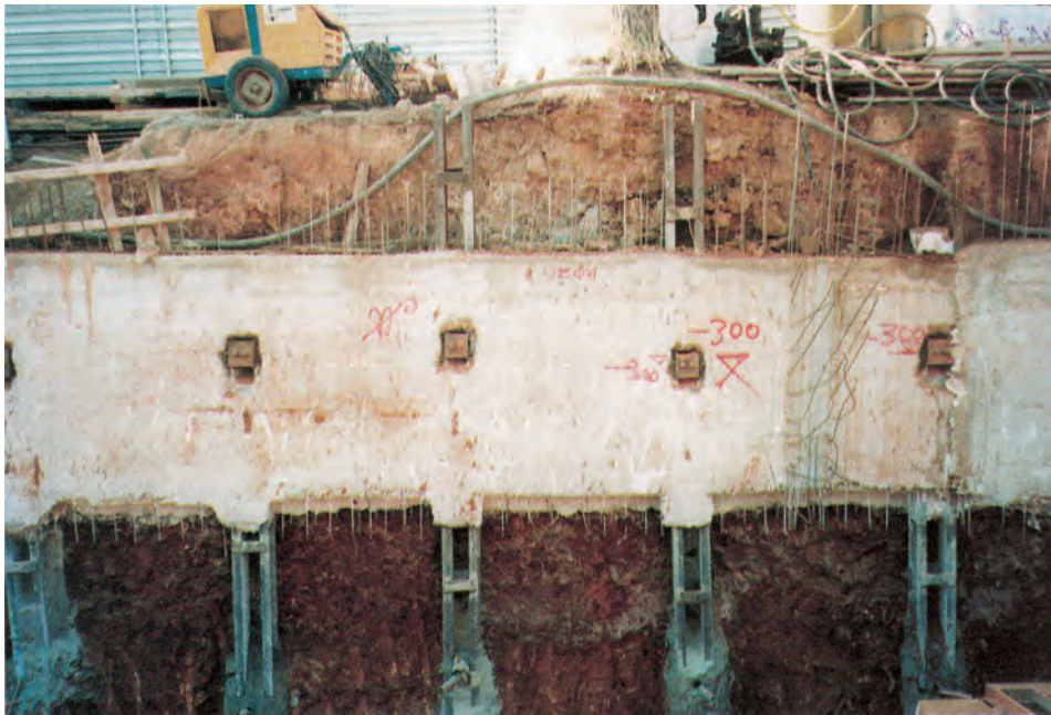
Φωτ. 1. Αντιστήριξη εκσκαφής
