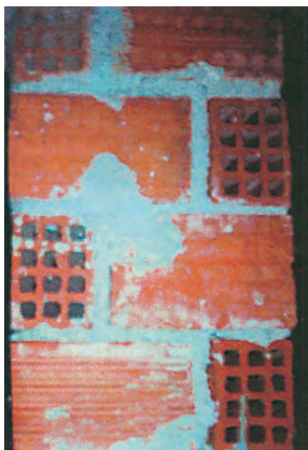
Φωτ. 10.22. Τομή υπερμπατικού τοίχου.
