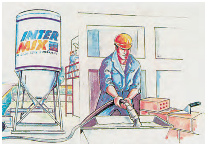
Σχ. 10.4. Δόμηση με έτοιμο κονίαμα.
