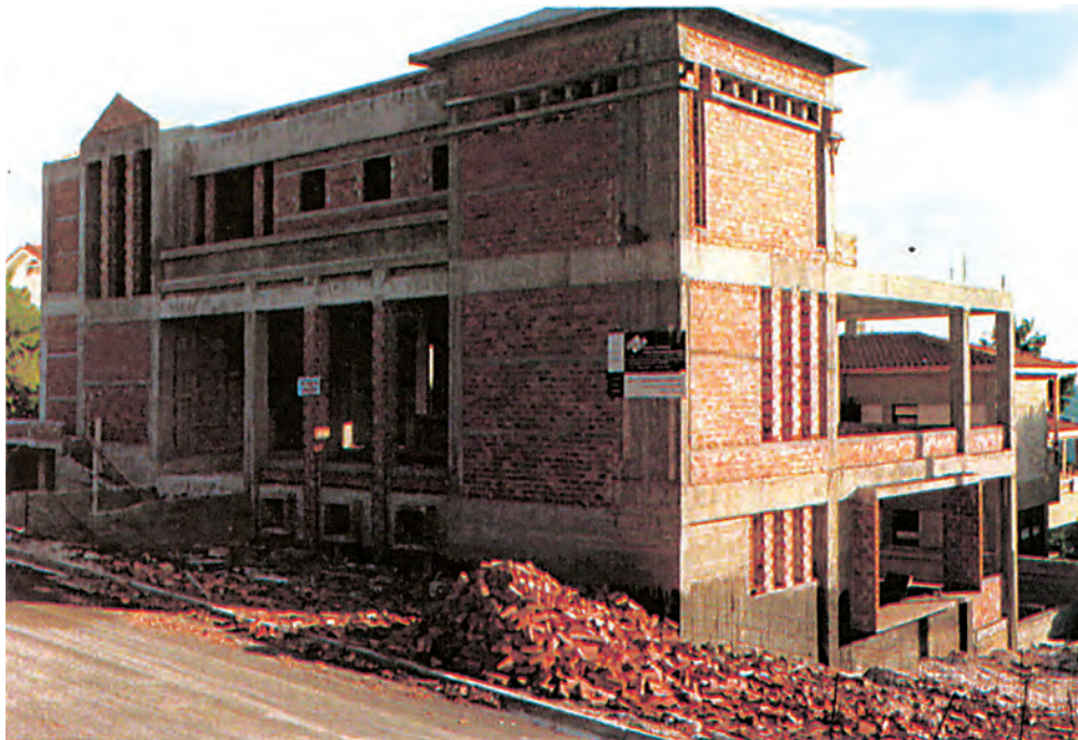
Φωτ. 10.2. Κτίριο με οπτοπλινθοδομή πλήρωσης.
