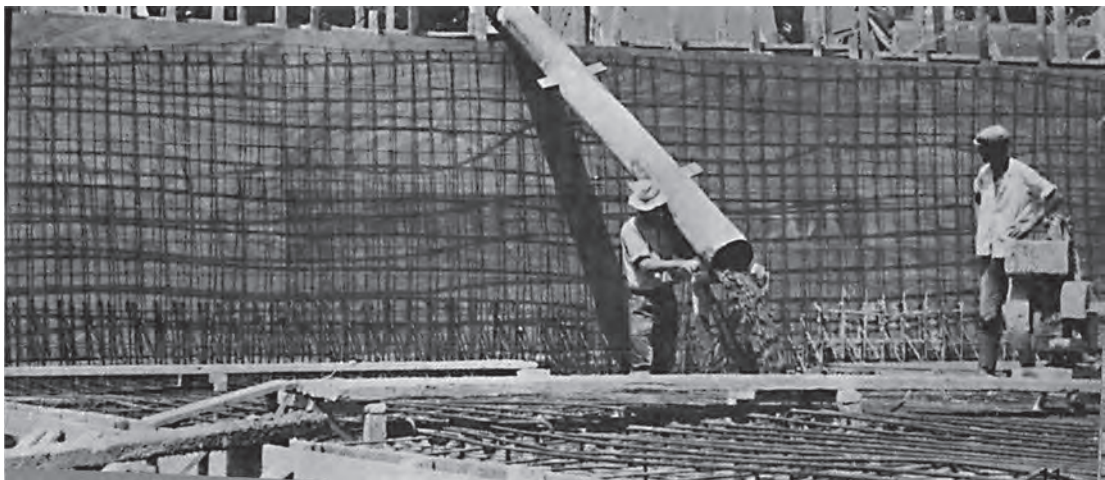
Σχήμα 16.10 Σκυροδέτηση σε εξέλιξη.
