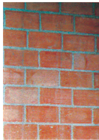
Φωτ. 10.6. Ορθοδρομικός τοίχος (όψη).
