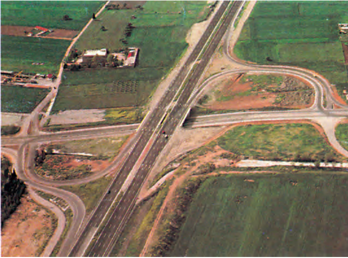
Φωτ. 1.1. Αυτοκινητόδρομος Κατερίνης-Θεσσαλονίκης
