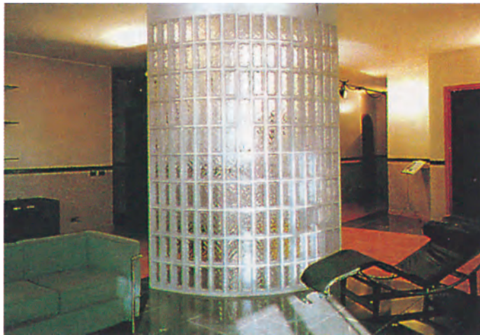
Φωτ. 10.31. Υαλότουβλα σε εσωτερικό χώρο.
