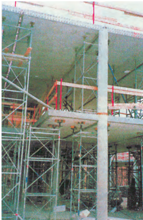
Φωτ. 13.11. Προκατασκευασμένη κατασκευή από οπλισμένο σκυρόδεμα.
