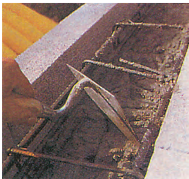
Φωτ 10.29. Περιμετρικό σενάζ από οπλισμένο σκυρόδεμα.
