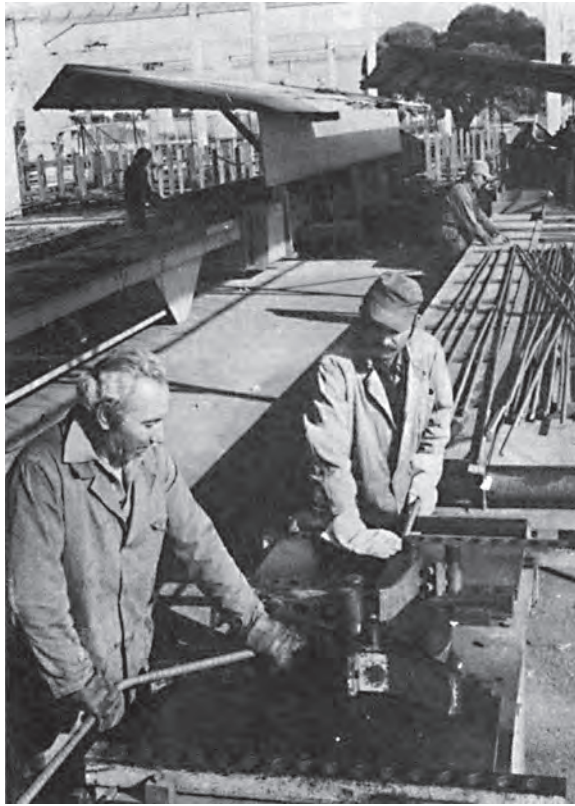
Σχήμα 16.9 Κάμψη οπλισμού με το ειδικό μηχάνημα.
