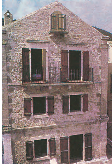
Φωτ. 11.8. Μετά την αποκατάσταση (1980).
