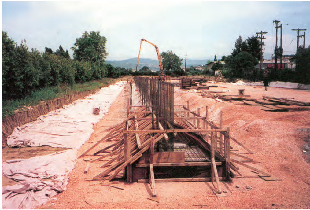
Φωτ. 1. Κατασκευή πεδילוδοκού.
