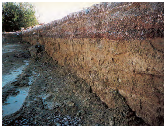
Φωτ. 1. Τομή εδάφους σε όρυγμα
