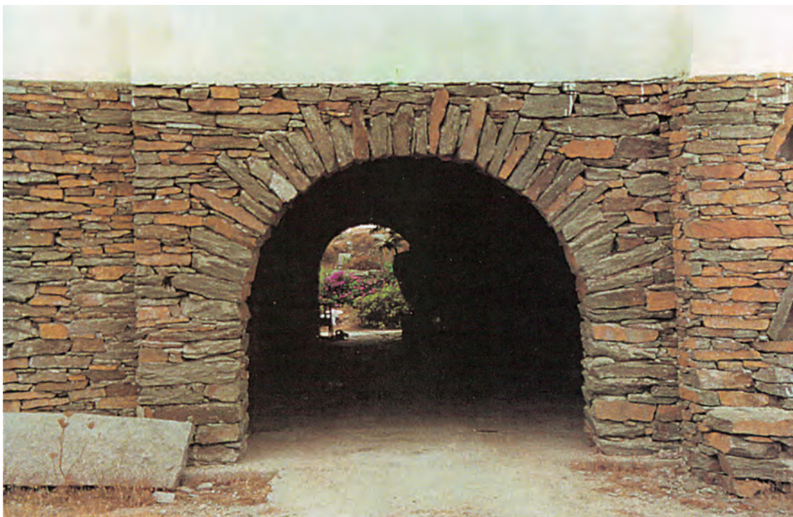
Φωτ. 9.16. Αψίδα σε πλακολιθοδομή στη Τζα.
