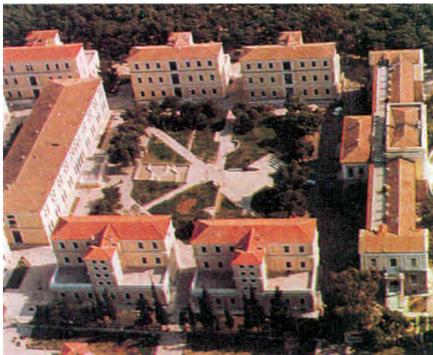
Φωτ. 1.32. Τα Δικαστήρια της Σχολής Ευελπίδων.
