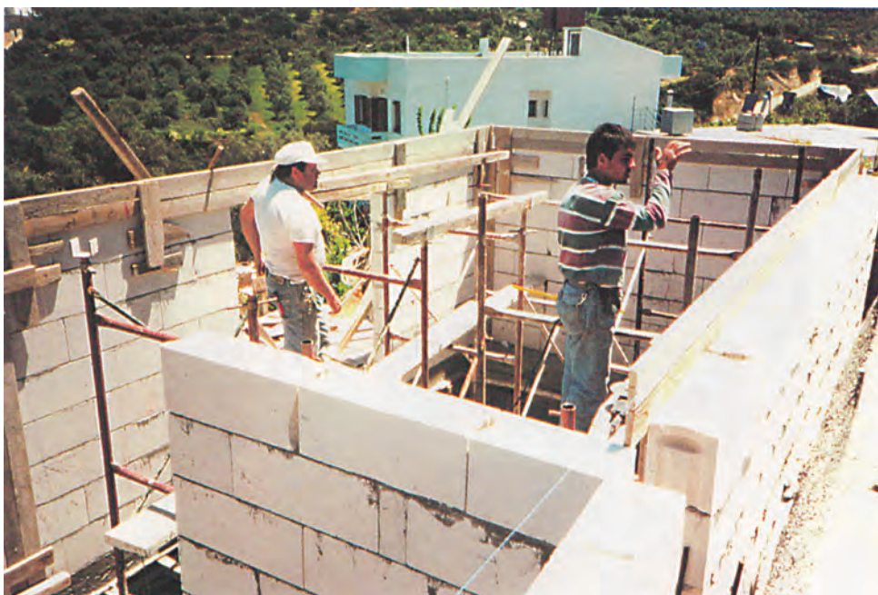
Φωτ. 10.28. Φέροντες τοίχοι με τεχνητούς πλίνθους από κυψελωτό κονίαμα.
