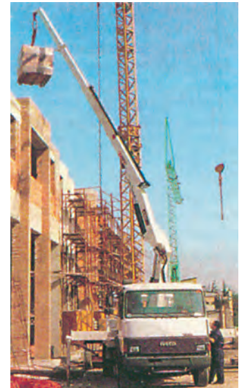
Φωτ. 10.3.β. Μεταφορά στη θέση εργασίας.
