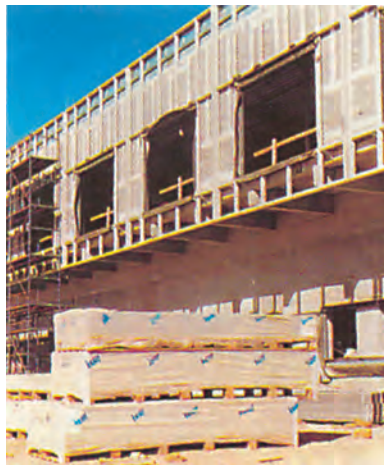
Φωτ. 12.3. Τσιμεντοσανίδες στο κτίριο του Κεντρικού Αεροσταθμού.
