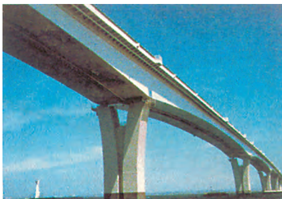
Φωτ. 13.8. Γέφυρα από οπλισμένο σκυρόδεμα.
