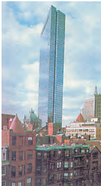
Φωτ. 13.4. Πύργος John Hancock στη Βοστώνη, ΗΠΑ.
