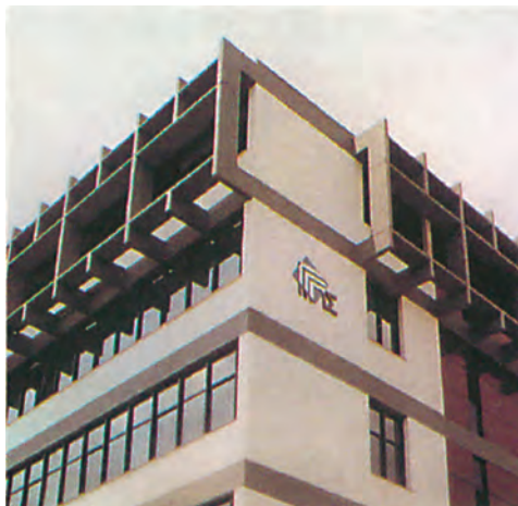
Φωτ. 12.2. Χυτοί τοίχοι και περσίδες από σκυρόδεμα.
