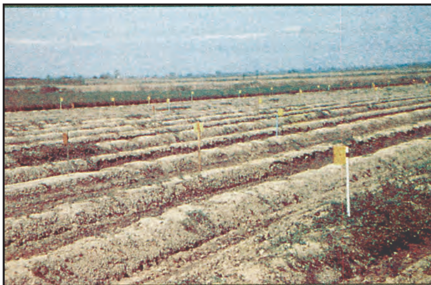
Ε ι κ ό ν α 2 . 2 9 Κατασκευή αναβαθμίδων για την προστασία του εδάφους από τη διάβρωση
