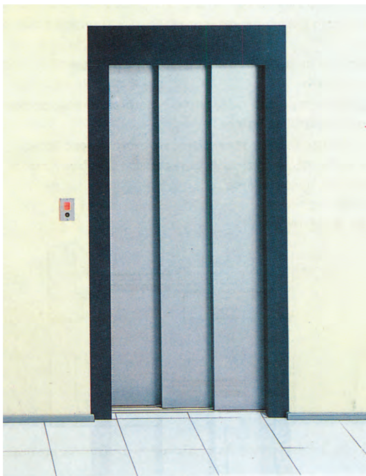
Σχέδιο 3.7β Τηλεσκοπική θύρα πλευρικού ανοίγματος
