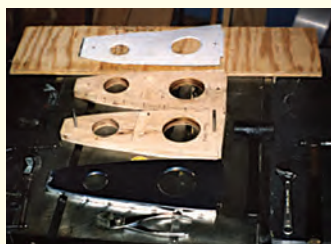
α) Καλούπια οξιάς και έλασμα που έχει το σχήμα του αναπύγματος της προς κατασκευή εγκάρσιας νεύρωσης.
