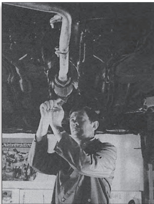
Σχήμα 3: Εργασία τοποθέτησης του καταλύτη.
