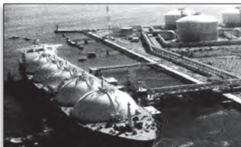
Εικόνα 7.1.7 Εγκαταστάσεις μεταφόρτωσης υγροποιημένου φυσικού αερίου στις ΗΠΑ
