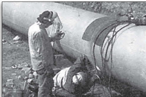
Εικόνα 7.1.8 Κατασκευή αγωγού μεταφοράς φυσικού αερίου στη Σιβηρία
