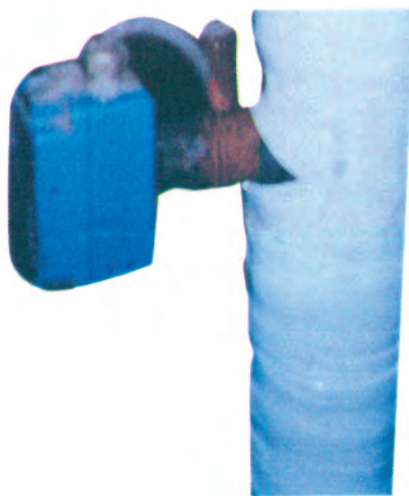
Σχήμα 1-14: Ελεγκτής ροής (flow switch) πάνω σε σωλήνα
