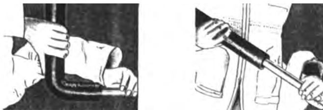
Σχήμα 4.5 Η μόνωση των σωλήνων ψυκτικού
