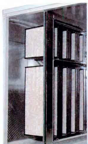
Σχήμα 8-49: Ηχοπαγίδες σε ΚΚΜ.
