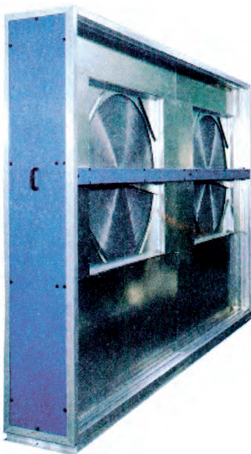
Σχήμα 8-61: Τμήμα περιστροφικών εναλλακτών ΚΚΜ (εξοικονομητών ενέργειας).
