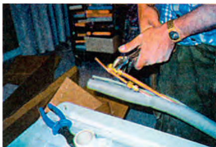
Εικόνα 6.5: Προετοιμασία σύνδεσης των αναμονών των χαλκοσωλήνων της εσωτερικής μονάδας.
