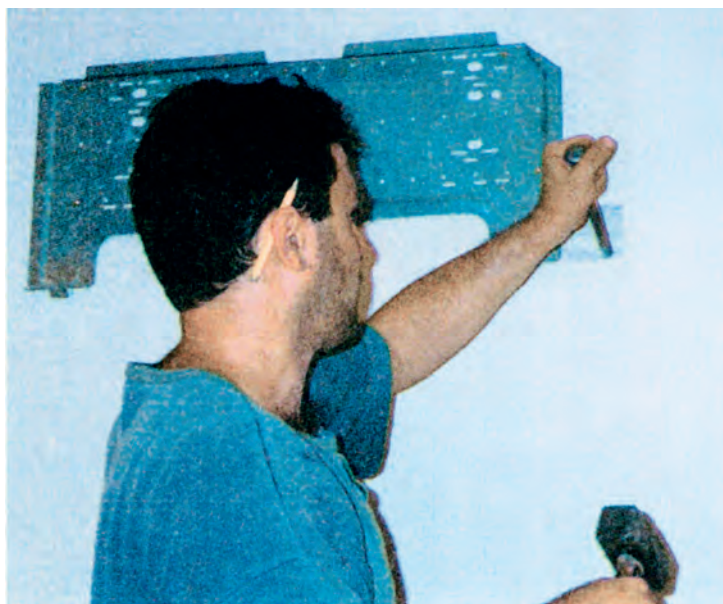
Εικόνα 6.2: Τοποθέτηση της μεταλλικής βάσης για το κρέμασμα της εσωτερικής μονάδας. Άνοιγμα της τρύπας (δεξιά της βάσης, αφού η εσωτερική μονάδα έχει τις αναμονές των χαλκοσωλήνων στο δεξιό άκρο της) για τη σύνδεση με την εξωτερική μονάδα.
