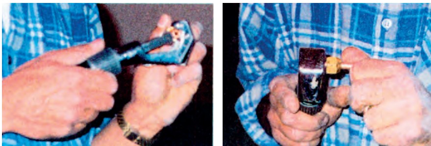
Εικόνα 6.6: Εκτόνωση και εκχείλωση των χαλκοσωλήνων.
