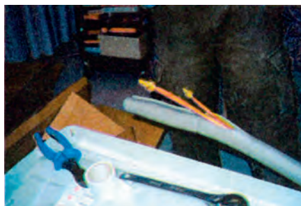
Εικόνα 6.5: Προετοιμασία σύνδεσης των αναμονών των χαλκοσωλήνων της εσωτερικής μονάδας.
