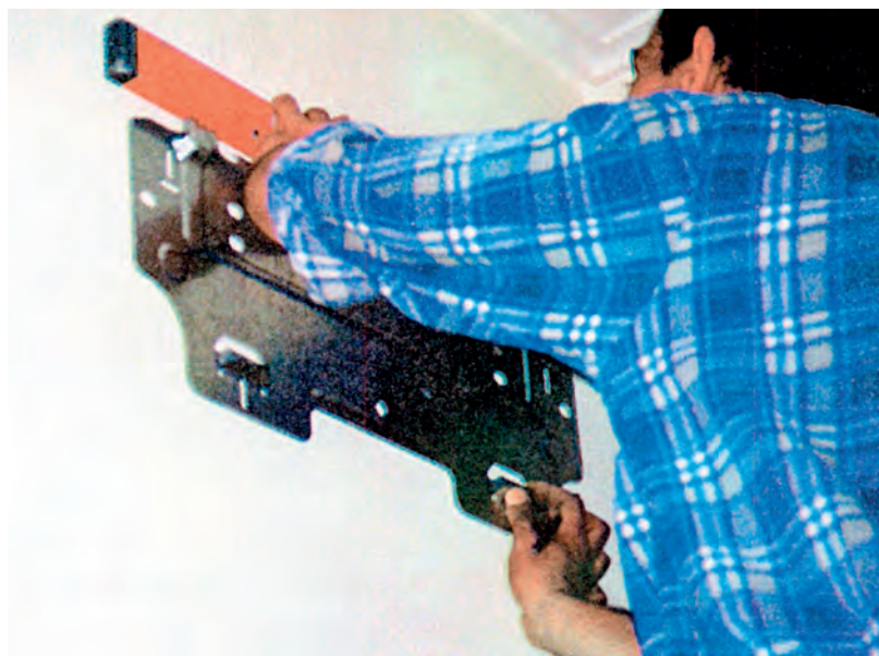
Εικόνα 6.1: Τοποθέτηση μεταλλικής βάσης στήριξης για να σημειωθούν τα σημεία που θα ανοιχθούν οι τρύπες.
