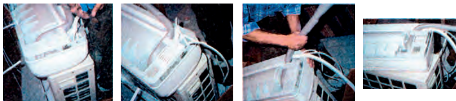
Εικόνα 6.9: Διαδικασία περιστροφής των χαλκοσωλήνων της εσωτερικής μονάδας στην επιθυμητή πλευρά της.
