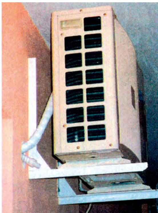
Εικόνα 7.2: Εξωτερική μονάδα πάνω στη βάση στήριξης.
