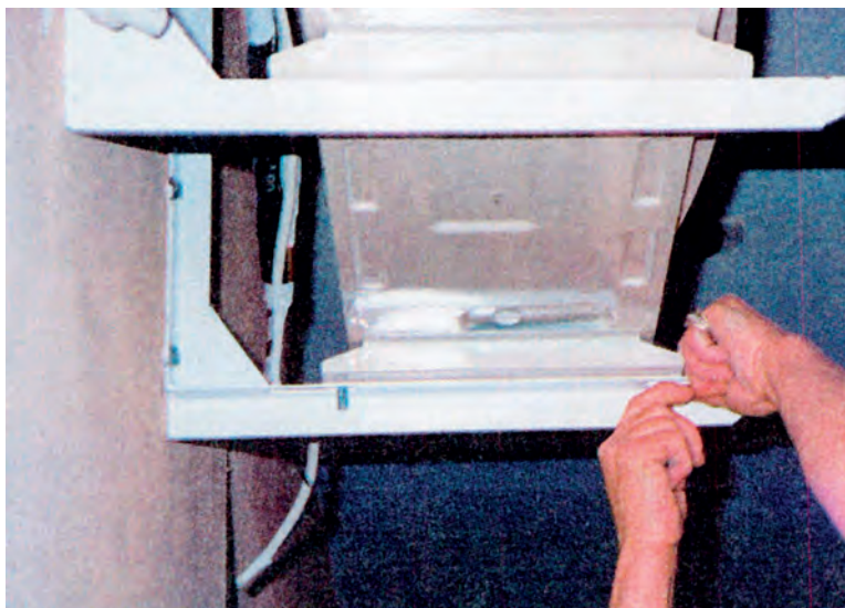
Εικόνα 7.3: Στερέωση της εξωτερικής μονάδας στη βάση στήριξης.
