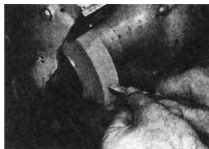
Σχήμα 4.32: Εκχόνδριση της δευτερεύουσας επιφάνειας ελευθερίας
