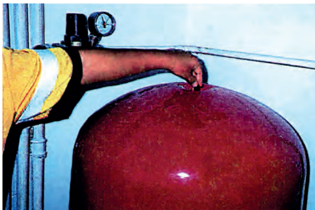
Εικ. (7.2δ) Έλεγχος δοχείου διαστολής (πίεση βαλβίδας για τη διαπίστωση της ύπαρξης αερίου μέσα σ' αυτό).
