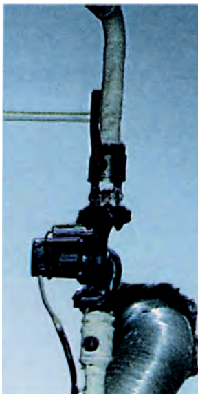
Εικ. (6.2α) Κυκλοφορητής με σφαιρικές βάνες.
