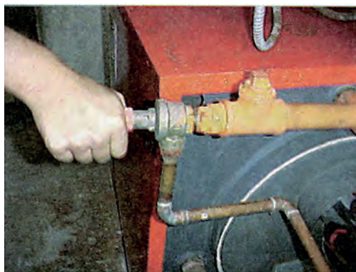
ΣΧ. 4.16.6β Η χρήση της βαλβίδας ασφαλείας βοηθάει στην ταχύτερη εκκένωση του λέβητα, αλλά καλό είναι να αποφεύγεται αυτή η μέθοδος, διότι δημιουργούνται προβλήματα στο ελατήριο και στη στεγανότητα.
