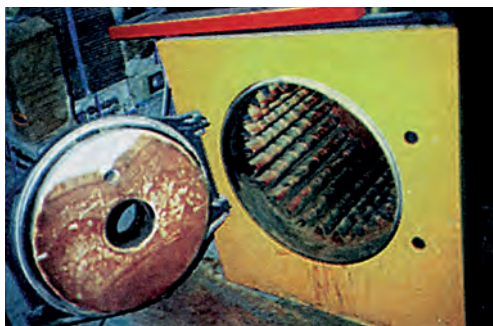
ΣΧ. 4.13α Αφανής διαρροή νερού στην εστία του λέβητα έχει αφήσει σημάδια στην πόρτα και τα τοιχώματά της. Η συνεχής μείωση της πίεσης του δικτύου και η ανάγκη αναπλήρωσης νερού οδήγησε γρήγορα στο άνοιγμα της εστίας, τον έλεγχο και αντιμετώπιση του προβλήματος.
