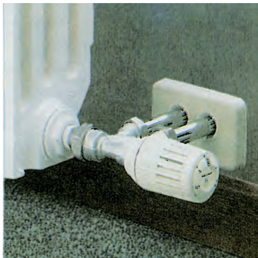
Εικ. (6.46) Σώμα συνδεδεμένο στο μονοσωλήνιο σύστημα κεντρικής θέρμανσης.
