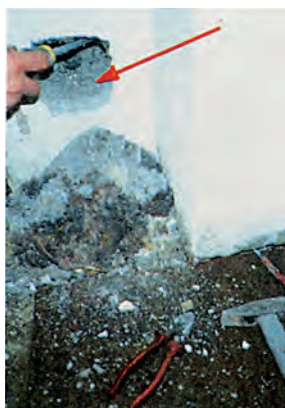
ΣΧ.5.4.α Άνοιγμα οπής καθαρισμού και κάλυψή της με πλακάκι.
