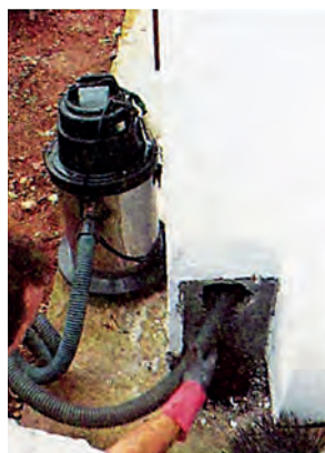
ΣΧ.5.4.α Άνοιγμα οπής καθαρισμού και κάλυψή της με πλακάκι.
