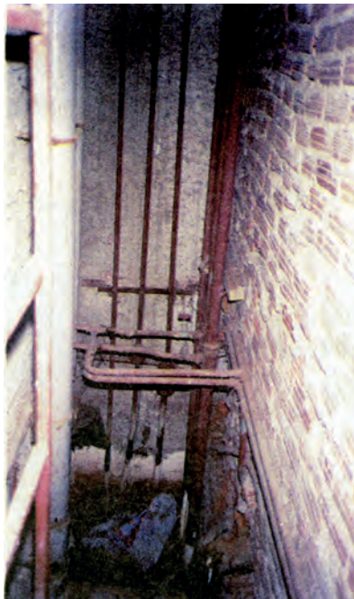
ΣΧ. 1.2α Σωλήνες μεταφοράς ζεστού νερού μέσα σε φρεάτιο κτιρίου. Η δυσκολία πρόσβασης στους σωλήνες (λόγω απουσίας ενδιάμεσων δαπέδων) οδήγησε στην εγκατάλειψη και διάβρωσή τους. Οι αιτίες πρέπει να αναζητηθούν, κυρίως, στη μελέτη και στην επίβλεψη του έργου. Υπάρχουν πολλά καινούρια κτίρια που τα εκτεταμένα δίκτυά τους χρειάζονται, ήδη, αντικατάσταση.
