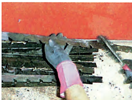
ΣΧ. 4.16.9β Τρίψιμο στροβιλιστήρων με συρματόβουρτσα.
