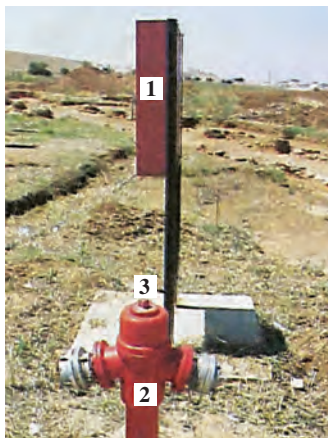
ΣΧ. 10.2.2.β Δίδυμο πυροσβεστικό υδροστόμιο σε υπαίθριο χώρο.
