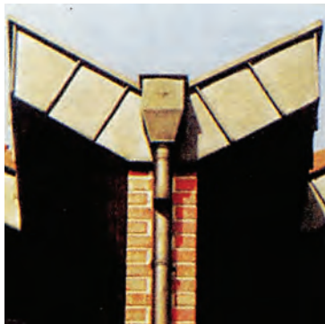
ΣΧ.4.2.γ Τα εμφανή δίκτυα αποχέτευσης βρόχινων νερών, όταν είναι κατασκευασμένα από χαλκό, διακοσμούν τις όψεις των κτιρίων.
