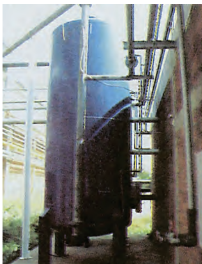
ΣΧ.9.2.2.β Δοχείο βιομηχανικού πιεστικού συγκροτήματος, χωρητικότητας 16\text{m}^3 , που λειτουργεί με πεπιεσμένο αέρα. Το δοχείο αυτό καλύπτει μικρές καταναλώσεις, χωρίς να ξεκινά η λειτουργία της αντλίας.
