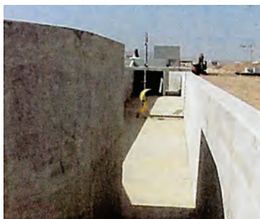
ΣΧ.5.3.3.β Μονάδα βιολογικού καθαρισμού, μεγάλου έργου του τόπου μας. Διακρίνονται οι δεξαμενές αερισμού και ένας από τους έλικες ανάδευσης των λυμάτων.
