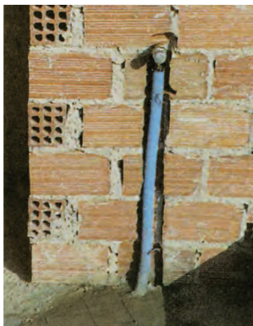
ΦΩΤ. 2.16.γ Σωλήνας τροφοδότησης εξωτερικής βρύσης. Η τοποθέτηση αυτών των σωλήνων γίνεται πριν από το σοβάτισμα για να μη τον σκάβουμε, στην αντίθετη περίπτωση. Αν ο σωλήνας είναι πλαστικός και αντικαθιστάμενος, τότε πριν από το σοβάτισμα τοποθετούμε μόνον το εξωτερικό του σπυράλι.
