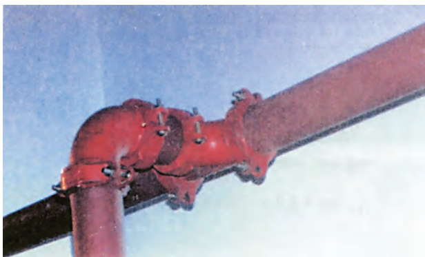
ΣΧ.8.2.2.ι Λυόμενη σύνδεση σε δίκτυο πυρόσβεσης.
