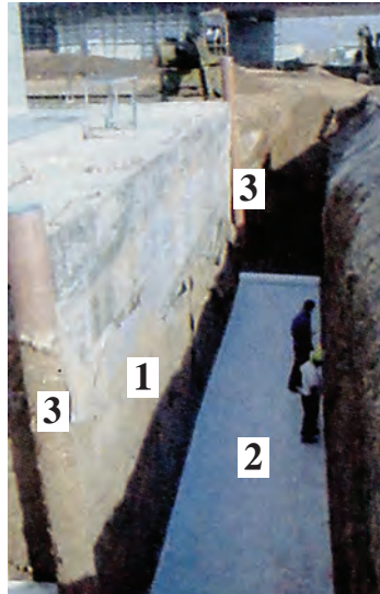
ΣΧ.4.9.2.γ Περιμετρική τάφρος αποστράγγισης υπογείων υδάτων. Διακρίνονται ο τοίχος του υπογείου (1), το νάilon που σκεπάζει το χαλίκι (2) και ο σωλήνας μέσα στον οποίο τοποθετείται η αντλία απομάκρυνσης των νερών (3).
