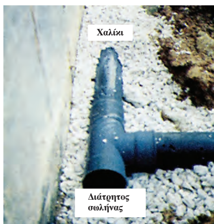
ΣΧ.4.11.β Τοποθέτηση σωλήνα αποστράγγισης υπογείων υδάτων.
