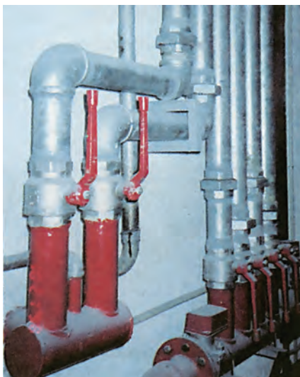
ΣΧ. 10.3.1.α Δίκτυο πυρόσβεσης κατασκευασμένο από γαλβανισμένους σιδηροσωλήνες. Οι ενώσεις των σωλήνων γίνονται με σπείρωμα.
