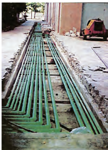
ΣΧ.8.5.4.α Υπόγειο δίκτυο ύδρευσης κατασκευασμένο με πλαστικούς αυτοσυγκολλούμενους σωλήνες.
