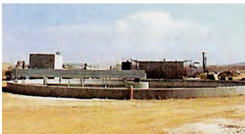
ΣΧ.5.3.3.γ Κυκλική δεξαμενή καθίζησης και περιστρεφόμενος μηχανισμός απόξεσης του πυθμένα.
