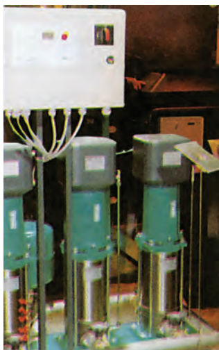
ΣΧ.9.2.3.α Αντλίες με ενσωματωμένο μετατροπέα συχνότητας.
