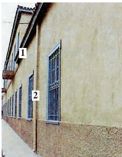
ΣΧ.4.2.δ Στο Τεχνολογικό Πάρκο Λαυρίου το Ε.Μ.Π., με τα έργα αναπαλαίωσης των κτιρίων, μας δίνει τη δυνατότητα να δούμε πώς κατασκευάζονταν παλαιότερα οι εγκαταστάσεις στον τόπο μας. Στη φωτογραφία διακρίνονται τα λούκια (1) και οι υδρορροές (2) των βρόχινων νερών.
