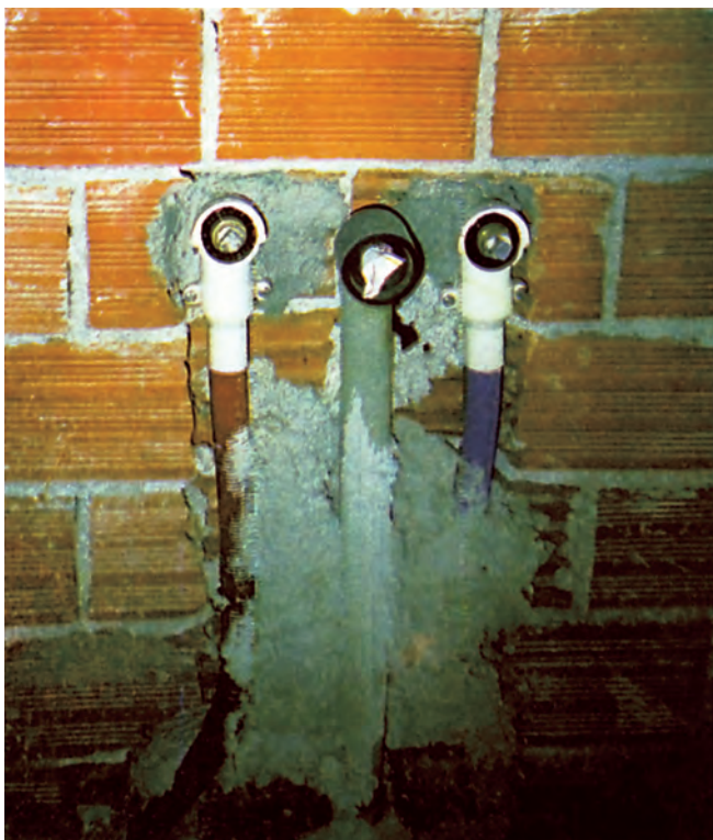
Σχ. 6-3.4β. Παροχή ζεστού-κρύου νερού με πλαστικούς σωλήνες PE και στο κέντρο η αναμονή της αποχέτευσης του νιπτήρα.
