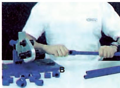
Σχ. 4-2.4α. (Α). Το κόψιμο των απαραίτητων τεμαχίων σωλήνα (PP). (Β). Δοκιμαστική συναρμολόγηση στον πάγκο.
