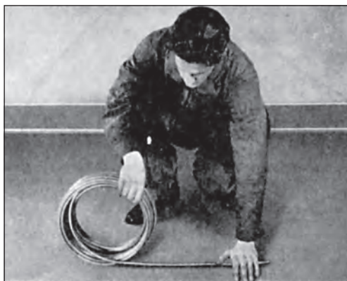
Σχ. 3-1.2α. Ο σωστός τρόπος ξετυλίγματος του μαλακού χαλκοσωλήνα.
