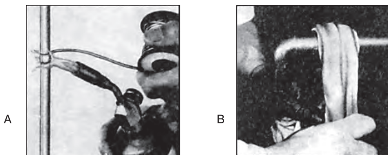
Σχ. 3-6.4γ. (Α). Η συγκόλληση των δύο τεμαχίων των χαλκοσωλήνων. (Β). Ο καθαρισμός των υπολειμμάτων της κόλλησης.
