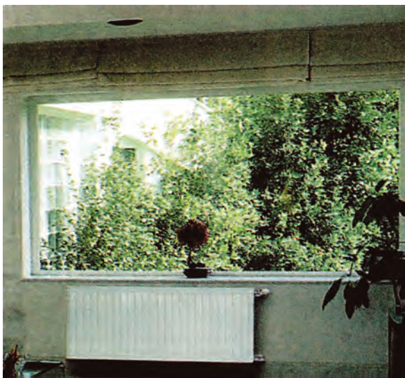
Εικόνα 9.3α Θέση τοποθέτησης των σωμάτων.
