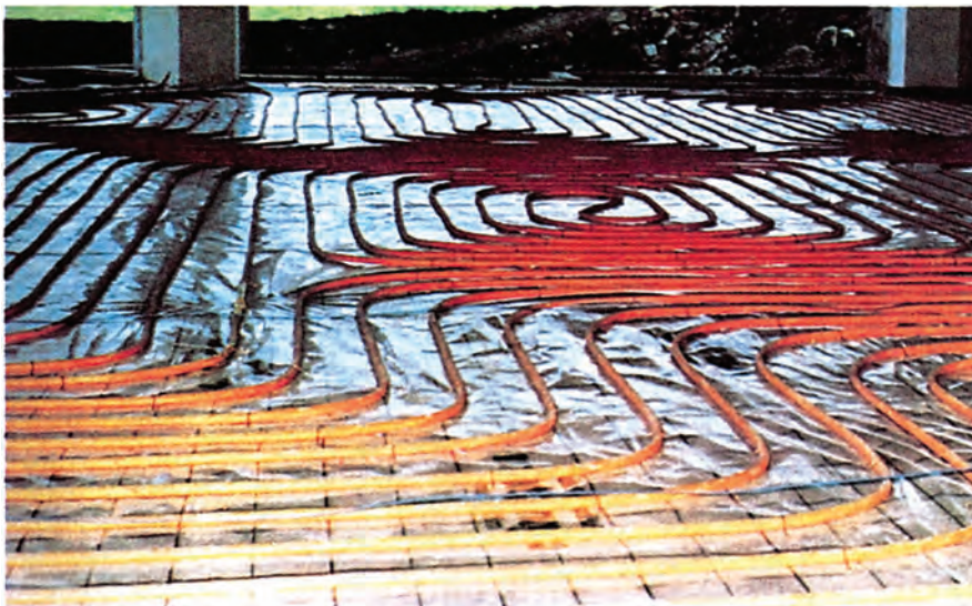
Εικόνα 1.8.3 Σκίτσο ενδοδαπέδιου συστήματος κεντρικής θέρμανσης.
