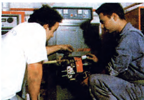
Εικόνα 7.9.1 Τοποθέτηση του καυστήρα στον λέβητα.
