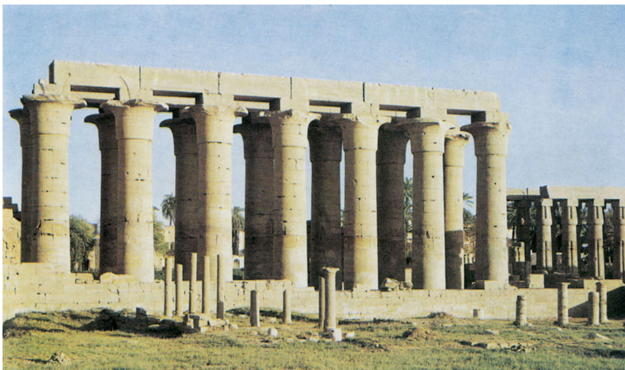
Εικ. 11. Κινοστοιχία του ναού του Άμμωνα, Λούξορ, 18η δυναστεία (1400-1360 π.Χ. περίπου), ύψος κίονα 22,5 μ. Η κινοστοιχία αυτή έχει μήκος 53 μ. και αποτελείται από επτά παπυρόσχημους κίονες στην κάθε πλευρά. Οι κίονες μοιάζουν με τεράστια πέτρινα φυτά παπύρου.
