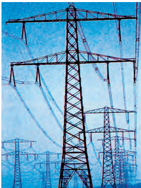
Εικ. 6.8. Κατασκευές πυλώνων για μεταφορά ενέργειας.
