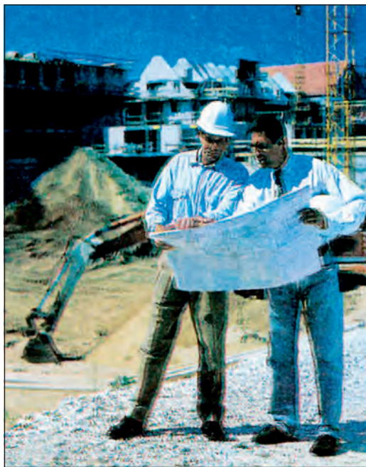
Εικ. 6.5. Εκσκαφές για θεμελίωση κτιρίου.
