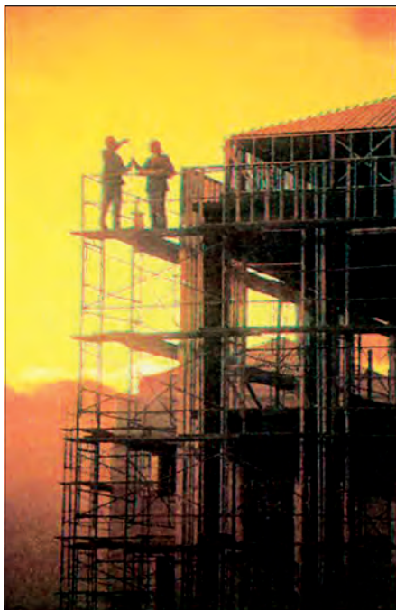
Εικ. 6.1. Σκαλωσιά για την κατασκευή του σκελετού που θα φέρει τα φορτία στο κτίριο που κατασκευάζεται.
