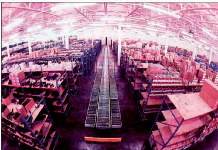
Εικ. 6.11. Βιομηχανικός χώρος με οροφή με μεγάλα ανοίγματα χωρίς ενδιάμεσες στηρίξεις για αποθήκευση εξαρτημάτων παραγωγής αυτοκινήτων.
