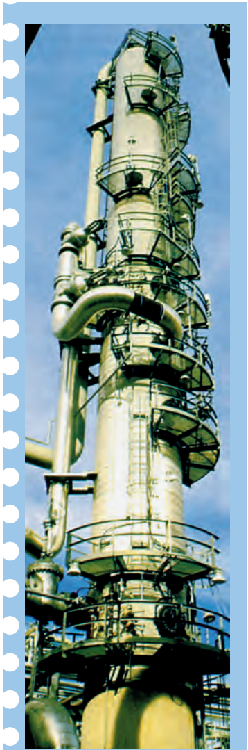
Μια αποστακτική στήλη ατμοσφαιρικής πίεσης με ύψος 50 m και διάμετρο 9 m έχει ικανότητα διύλισης περίπου 10^7 τόνων πετρελαίου το χρόνο.
