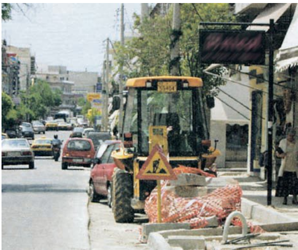
Εικόνα 31.1: Κατασκευή νέων πεζοδρομίων
