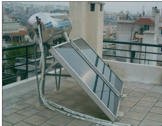
Εικ. 7.4 Τα δύο είδη θερμοσιφώνων: α) ηλεκτρικός, β) ηλιακός
