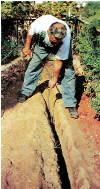
Εικ. 15.3 Άνοιγμα χαντακιού για την ασφαλή τοποθέτηση του καλωδίου μέσα στο έδαφος
