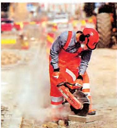
Εικ. 16.44 Ολοκληρωμένη προστασία, σε εργασία κοπής πλάκας με ειδικό μηχανικό κόπτη
