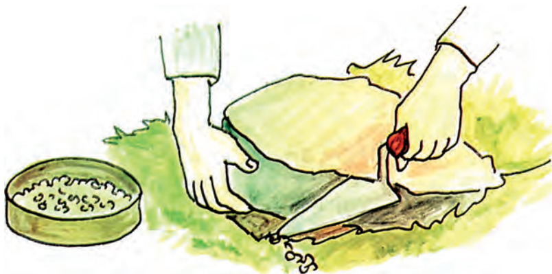
Εικ. 14.6 Τοποθέτηση πατήματος σε γκαζόν. Βάζουμε άμμο κάτω από την πέτρα ή την πλάκα.
