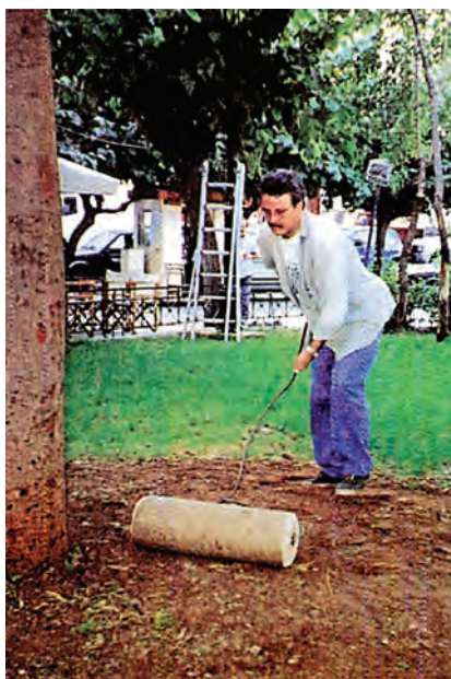
Εικ. 2.31 Εργασία κυλινδρίσματος της σπαρμένης επιφάνειας
