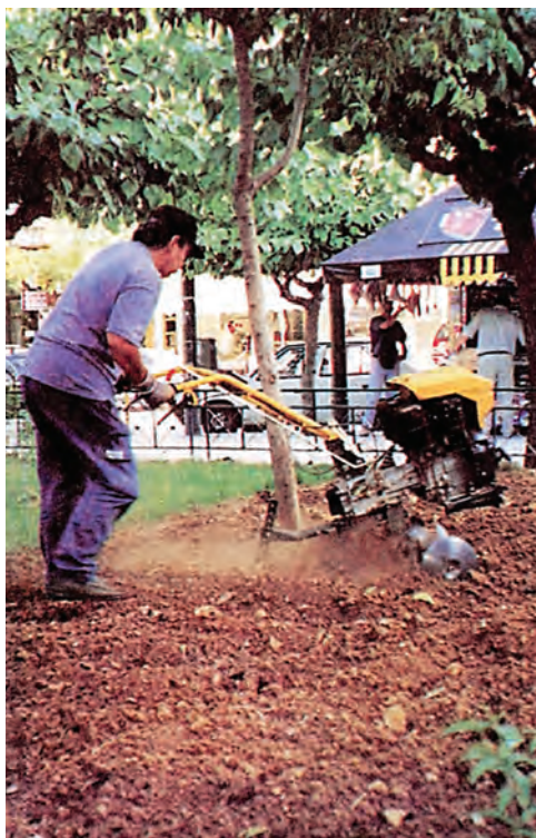
Εικ. 2.27 Φρεζάρισμα του τμήματος της επιφάνειας του χλοοτάπητα, που πρόκειται να γίνει επανεγκατάσταση.
