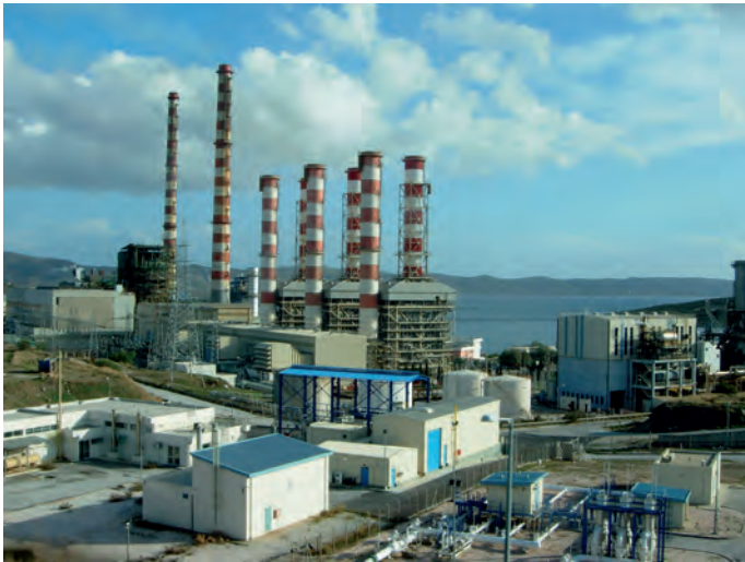
42.7 Λαύριο: θερμοηλεκτρικός σταθμός Δ.Ε.Η.
