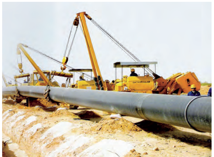
42.10 Κατασκευή αγωγού φυσικού αερίου
