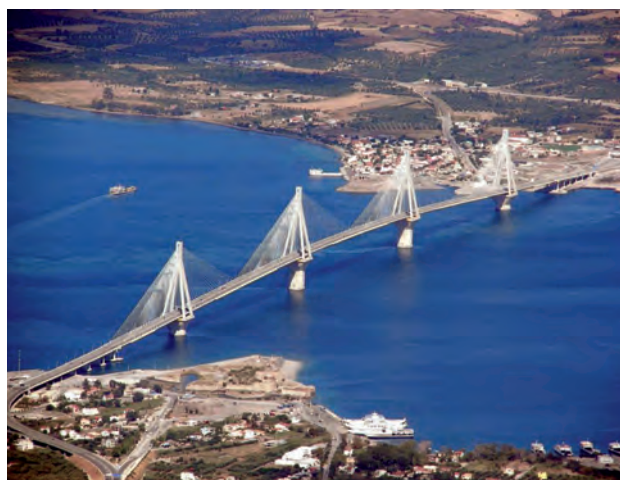
43.3 Γέφυρα «Χαρίλαος Τρικούπης», ένα μεγάλο ευρωπαϊκό τεχνικό έργο στην Ελλάδα
