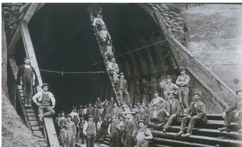
31.5 Ντιτρόιτ, Η.Π.Α.: Ηπειρώτες μαστόροι σε εργασίες κατασκευής σιδηροδρομικής γραμμής το 1927
